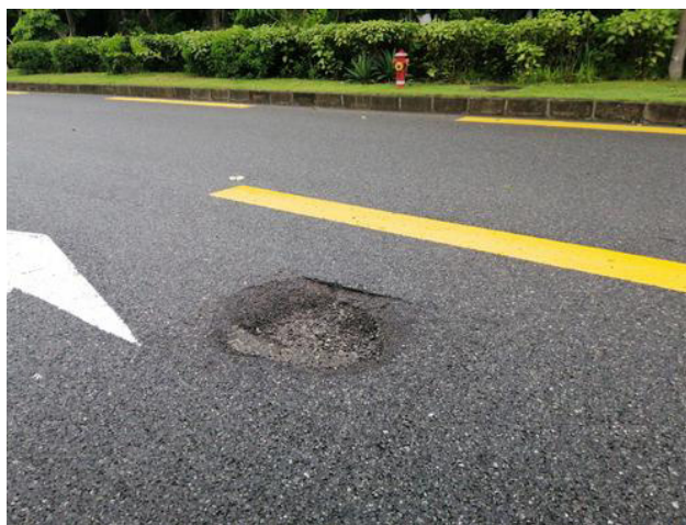
图 1 沥青路面凹陷问题
