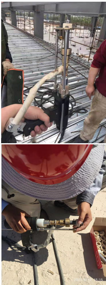
图5 剪力键安装、调节
