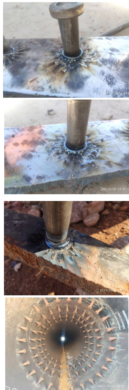
图6 剪力键焊接
