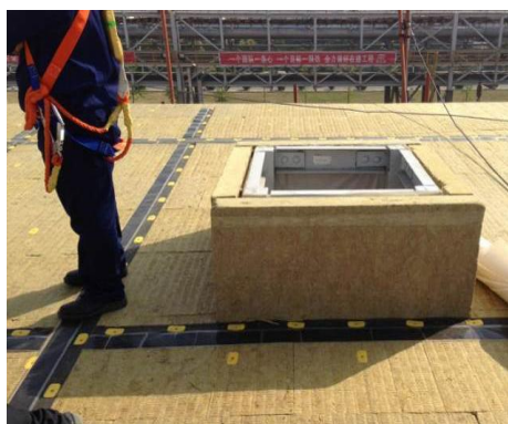
图5 搭接接缝处理
