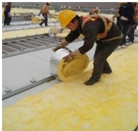
图4 玻璃棉(带铝箔贴面)铺设
