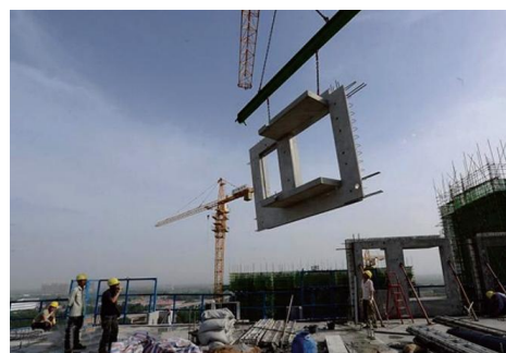
图1 预制装配式建筑施工现场实拍图
