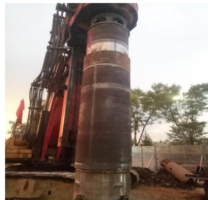
图8 连接第二节套筒
