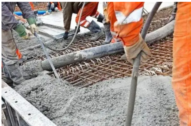
图2 清水混凝土振捣
