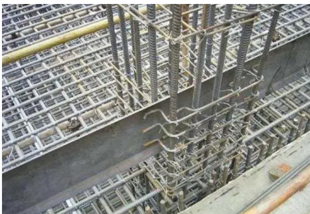
图1 清水混凝土钢筋安装
