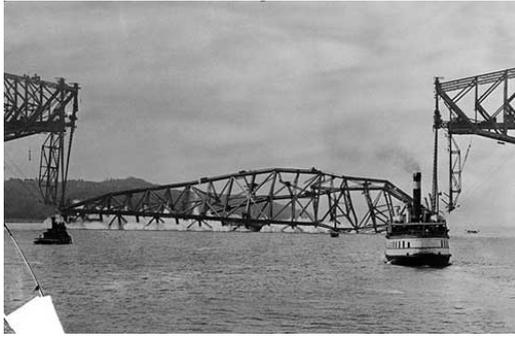
图1 加拿大魁北克桥的破坏形态
