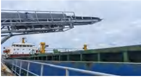
图 7 伸缩皮带装船机实物运行图
