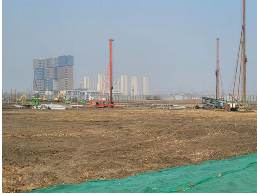
图 7 施工现场照片
