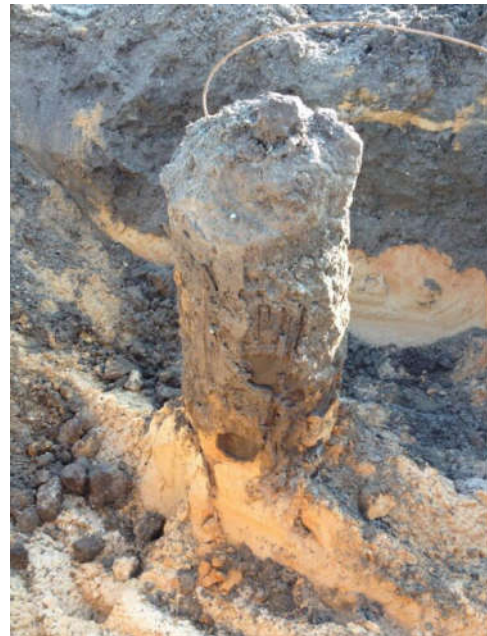
图 2 因泥浆比重过大导致摩擦型桩承载力检测不合格
