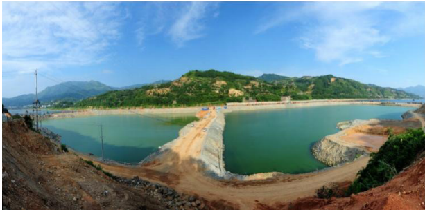
图2 连接段和纵向段围堰施工防渗墙设备投入情况
