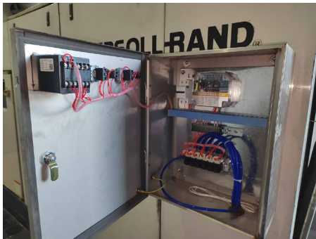
图 3 现场安装实拍
