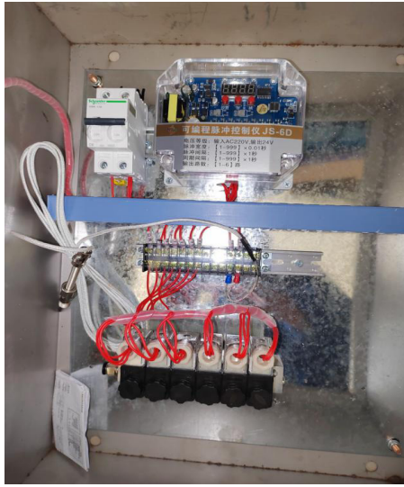
图 2 吹扫自动调节控制箱组装图
