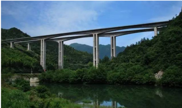
图 1 高速公路桥梁过渡段
