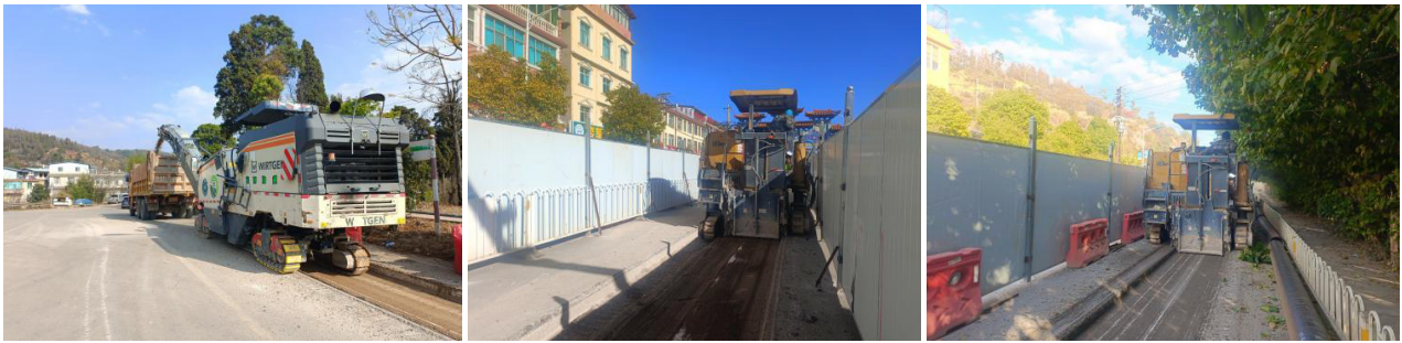
图4 沥青路面铣刨、废料输送一体化
