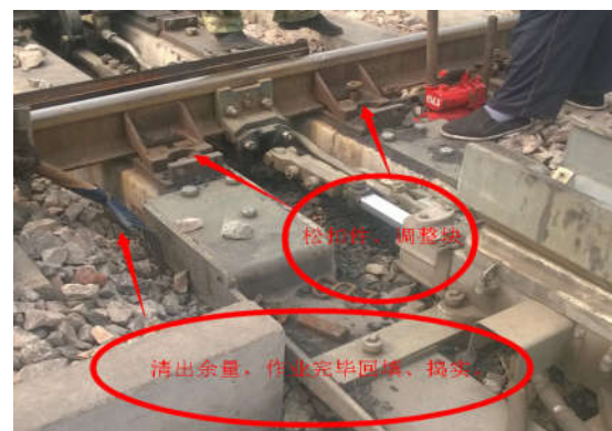
图5 ZYJ-7型转辙机不方正的常见处理方法
