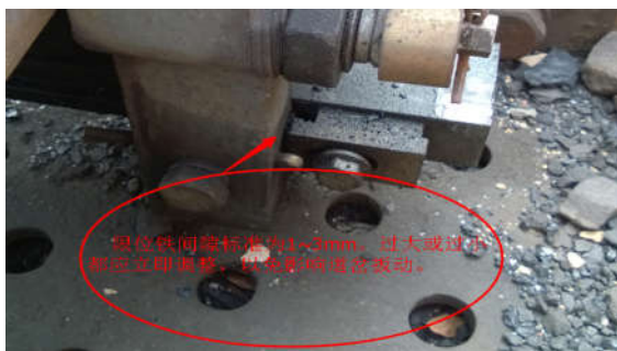
图6 外锁闭道岔限位铁的安装
