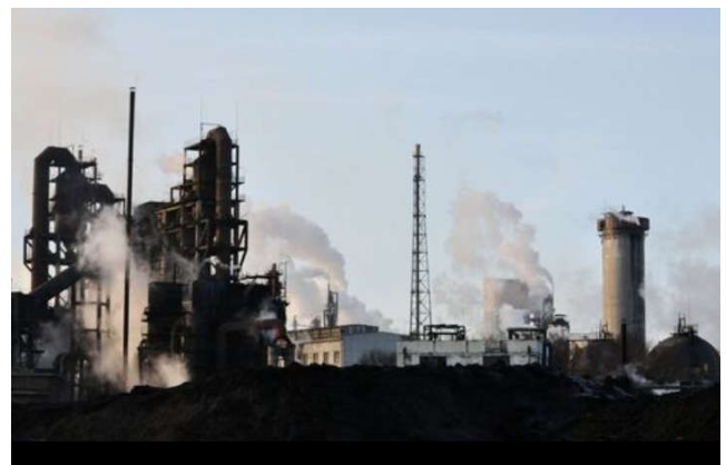
图1 煤化工废水排放工作的二次污染
