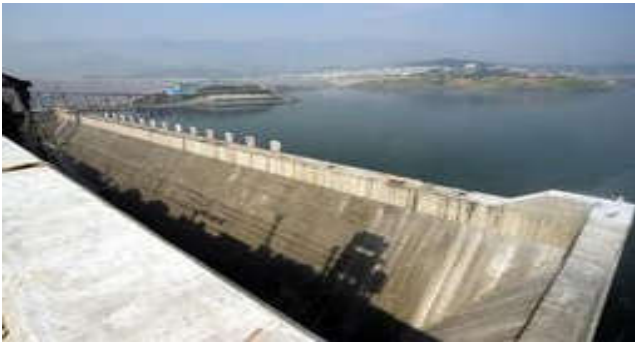
图1 混凝土围堰
