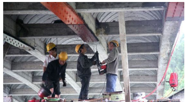
图1 粘贴钢板加固
