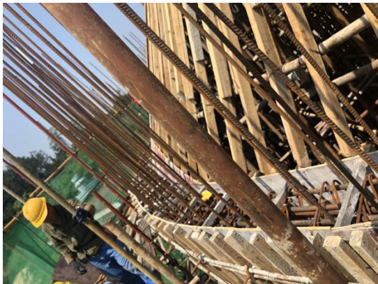
图3 内侧模板支架和木方调整
