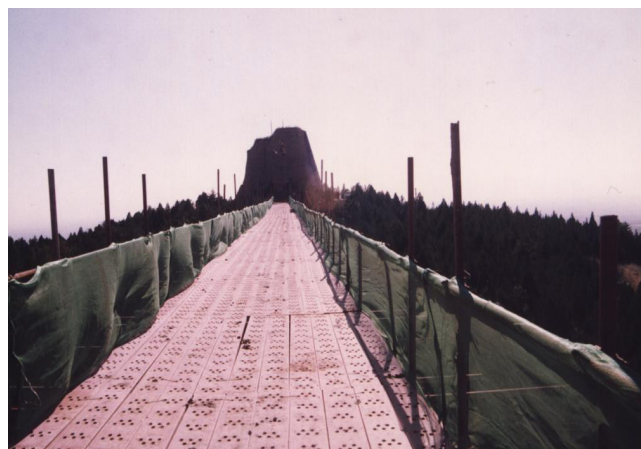
图 10 东乳阙遗址及保护工程搭设的空中施工通道
