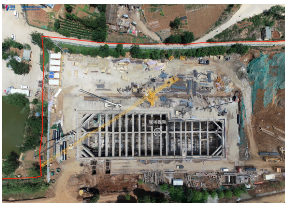
图 1 (b) 中国昆明七水厂应急供水工程 360 度全景形象进度平台截图
