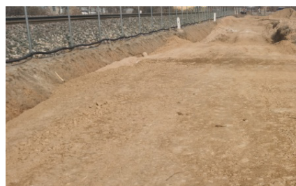
图 1 压实后的 A 组非冻胀填料
