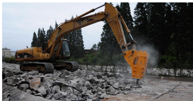
图2 废旧混凝土路面拆除循环利用—节材
