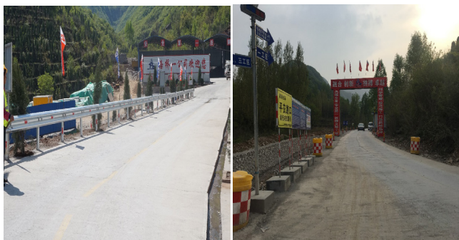
图1 施工便道永临结合—节地
