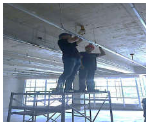
图 2 吊顶膨胀螺栓锚固承载力检测照
