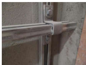
图 5 饰面砖墙面龙骨连接节点检查照
