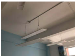
图 8 现场灯具负荷试验照
