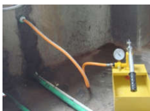
图 7 现场给水管打压试验照
