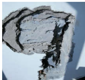
图 3 砖类隔墙抗震构造措施检查照
