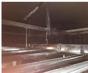
图 1 吊顶钢结构转换层检查照
