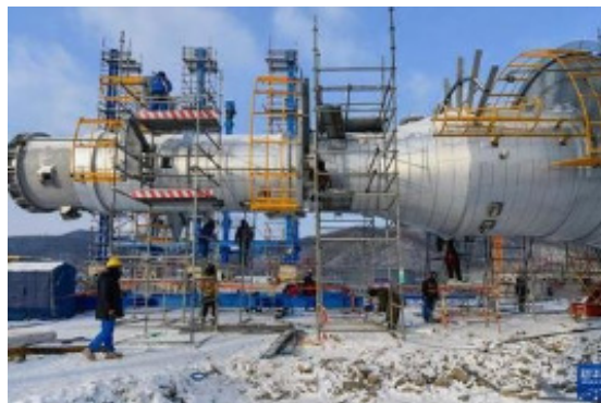
图 2 石油化工建设项目安全检查
