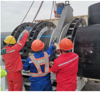
图1 电加热板插入，管端面吸热阶段
