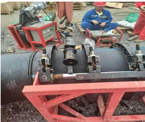
图 1 加热管材管件
