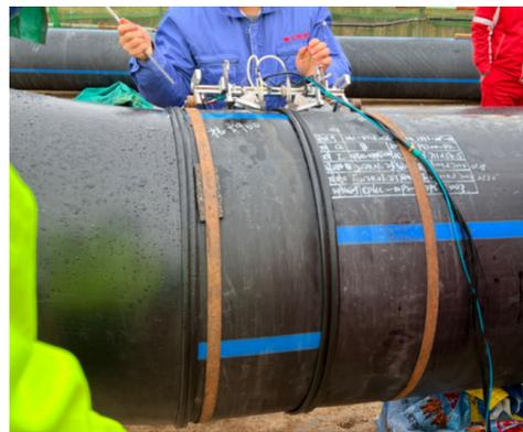
图3 相控阵检测实拍
