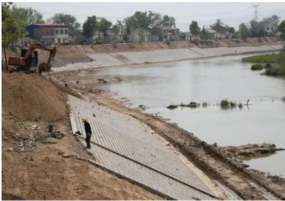
图1 正在进行的河道治理工程
