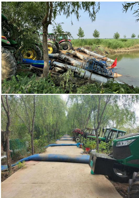
图3 拖拉机泵现场排水图
