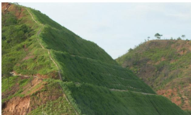
图 1：喷混植生植物护坡形式
