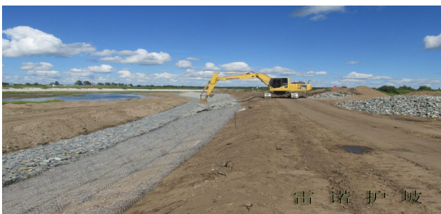
图2 石料填充施工图
