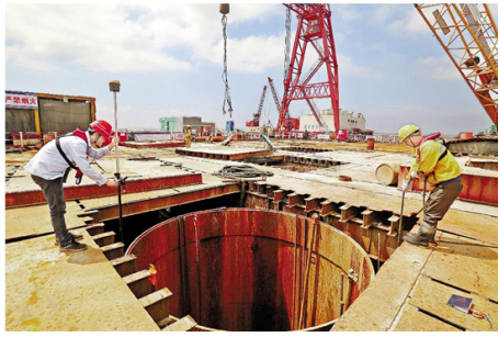
图 2 2# 楼成孔垂直度检测
