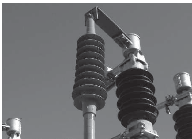
图3 制作成型电缆终端图
