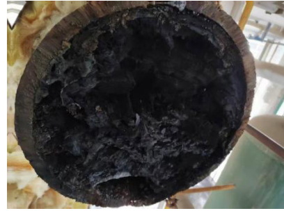
图3 合成气管道中部细灰堵塞
