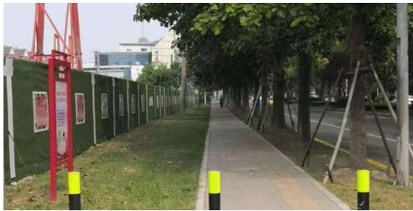
图 2 基坑南侧（同丰东路）
