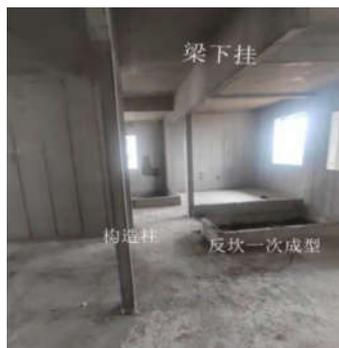
图 17 拆模后,成型质量
