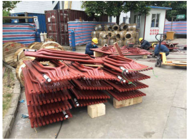
图 2 现场文明施工
