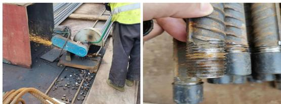
图3 现场钢筋加工
