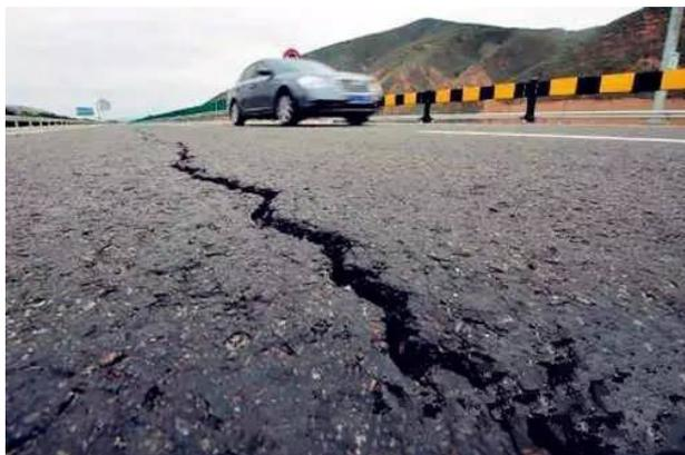
图1 沥青混凝土路面开裂
