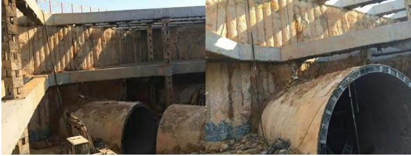
图 5 咬合桩切割开挖图
