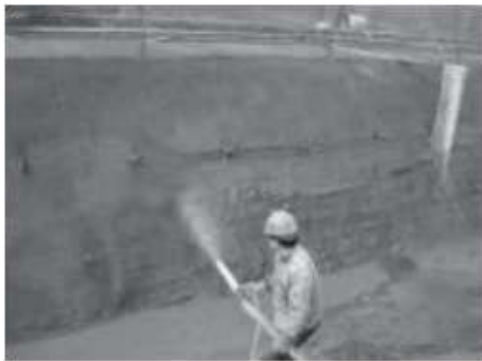
图 1 喷射混凝土支护
