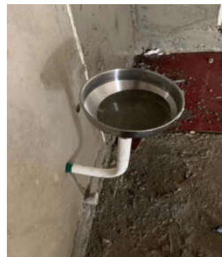
图 2 L 型注浆回流器
