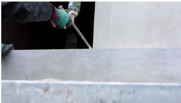
图8 打密封胶封闭
