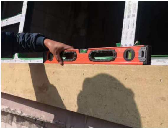
图7 装饰线条安装完成后进行自检
