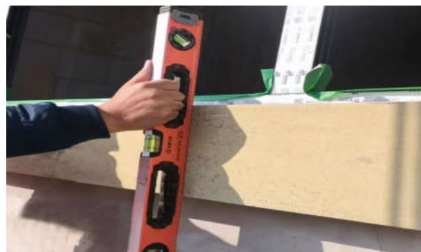
图5 装饰线条临时固定后进行自检
