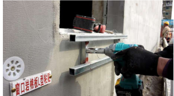
图3 连接件固定
