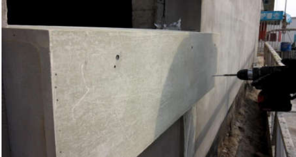
图6 装饰线条与方管固定
