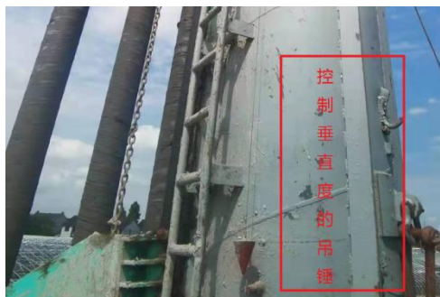
图1 控制钻机垂直度的吊锤
