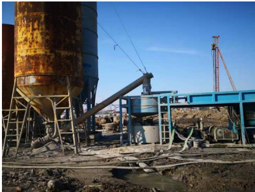
图 3 电脑控制的后料搅浆系统
