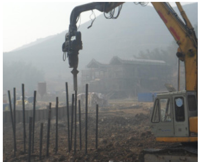
图5 夹持振动机械施工松木桩
