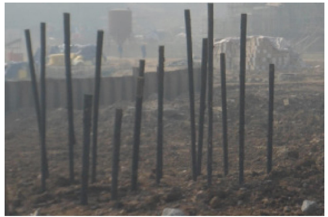
图4 安插松木桩至引好桩孔内
