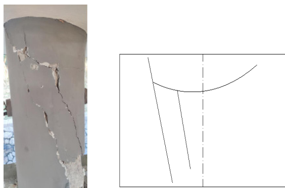
(a) 圆柱受剪压开裂照片 (b) 圆柱立面展开图
