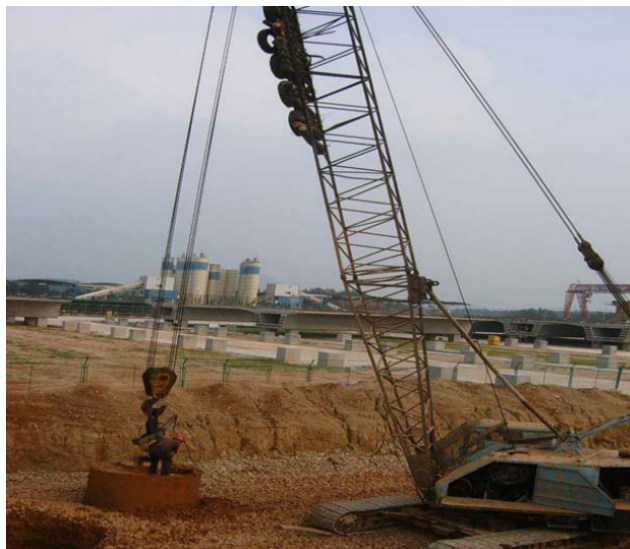
图1 强夯法处理技术应用现场实拍图
