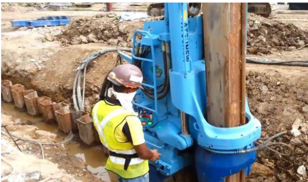
图2 静压力打桩示意图
