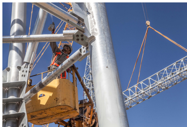
图 2 输电线路施工
