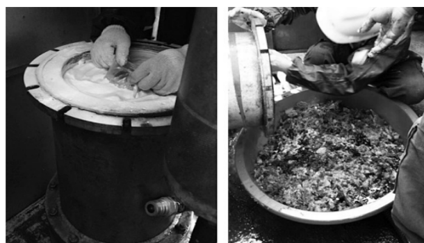
(a) 新更换的吸附剂 (b) 吸附饱和的吸附剂
